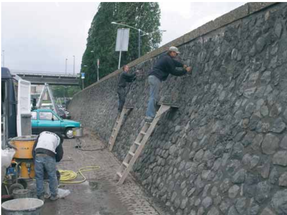
Machinaal voegen van een kademuur.
