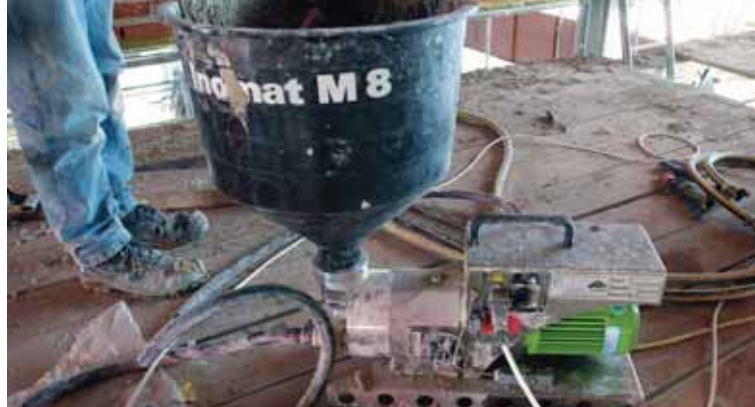
De pomp met voorraadbak voor de mortel, waaraan de slangen zijn aangesloten. Het witte snoer is voor de afstandsbediening.
