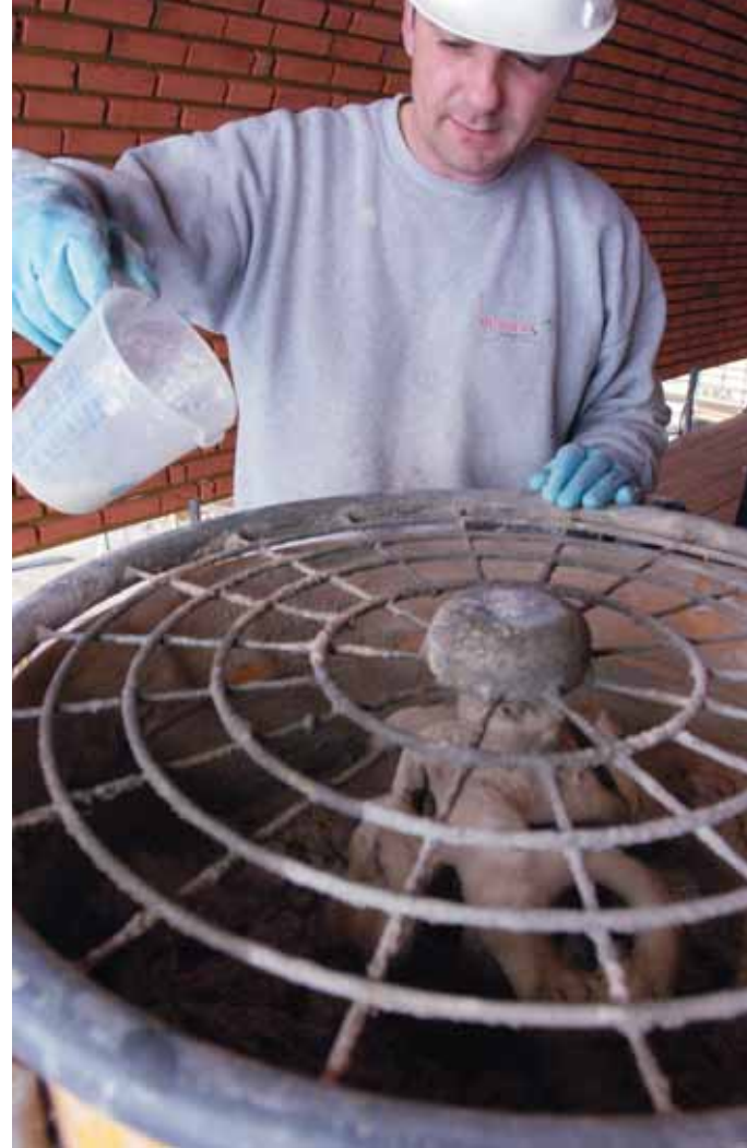
De dikte van de mortel is van groot belang en daarom worden bij het mengen op het laatst nog kleine beetje water toegevoegd.
