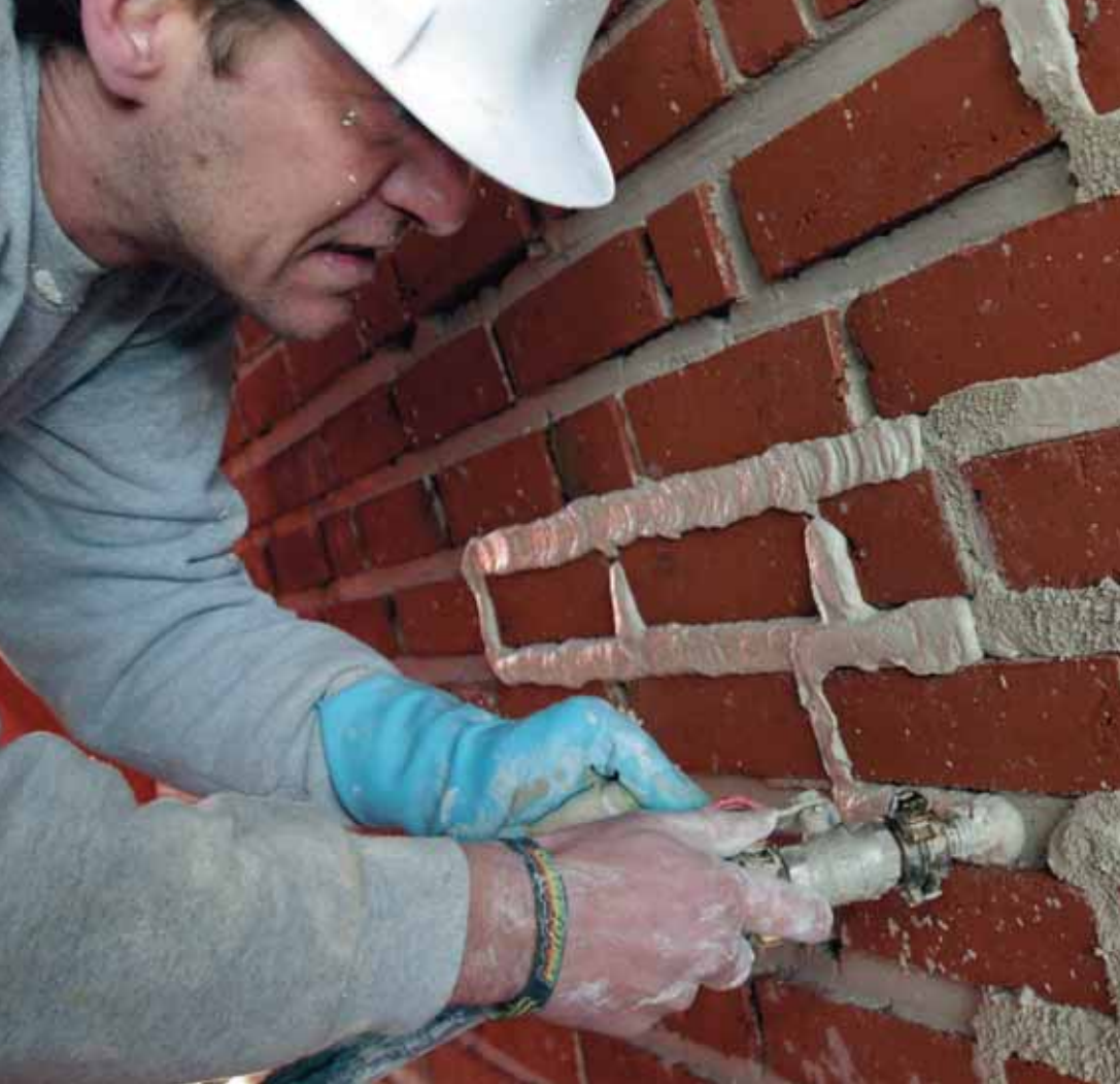
Edwin de Boer brengt een tweede laag mortel aan in de voegen van de boogmuur.
