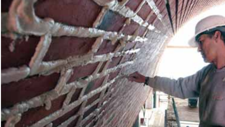
Voeger Edwin de Boer van het gelijknamige voegbedrijf uit Bolsward werkt de voegen af van een van de tien bogen van het nieuwe Huis voor Cultuur en Bestuur in Nijverdal. De muur is machinaal gevoegd.
