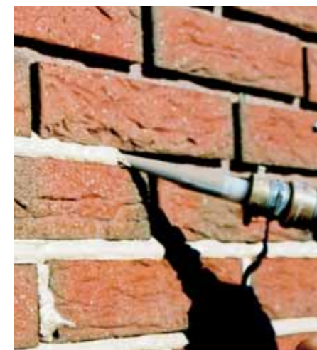
EEN NIEUWE ONTWIKKELING IS HET MACHINAAL VOEGEN MET SCHELPKALKMORTEL
