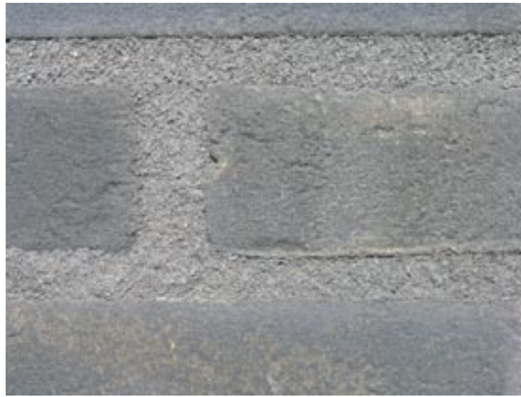
Links het metselwerk bij gebruik van een uitslagarme voegmortel en rechts zonder.
